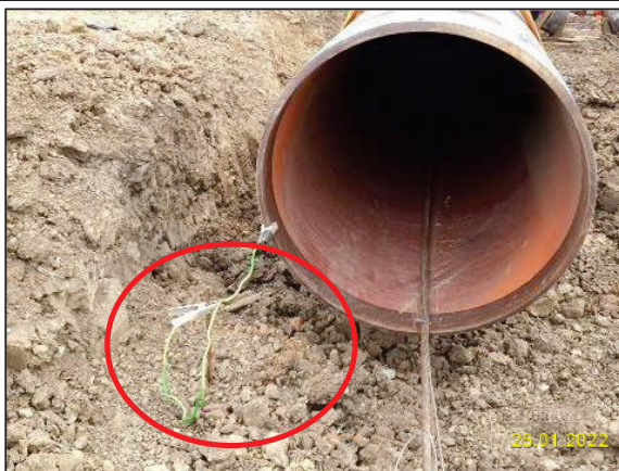
ค) การติดตั้งสายดินกับท่อบริเวณใต้สายส่งไฟฟ้า
