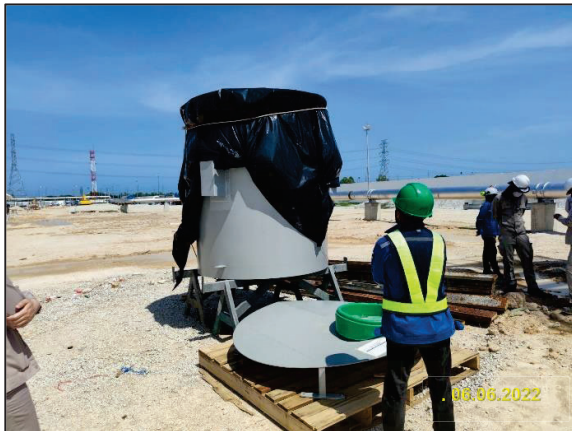
รูปที่ 2-45 ติดตั้งอุปกรณ์ควบคุมเสียง (Silencer) ที่ปล่องระบายก๊าซ (Vent Stack)
