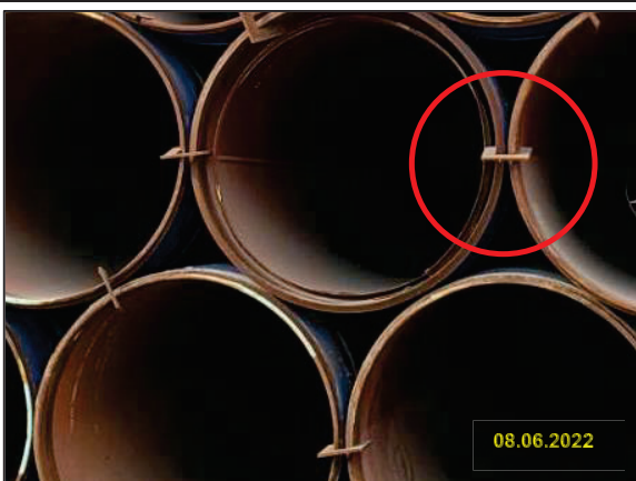
ข) การจัดวางท่อส่งก๊าซ และวัสดุป้องกันการพังทลาย
